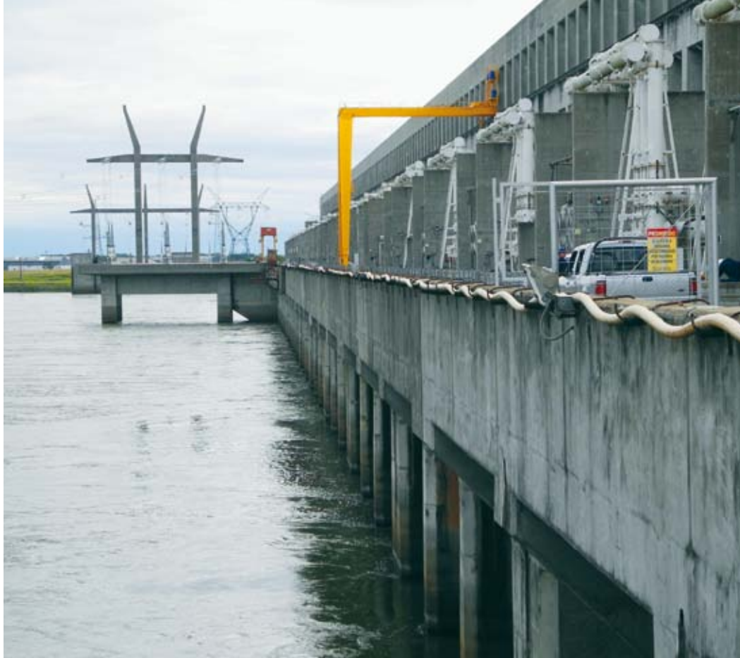
CORONAMIENTO DE REPRESA HIDROELÉCTRICA YACYRETÁ, Argentina-Paraguay.
