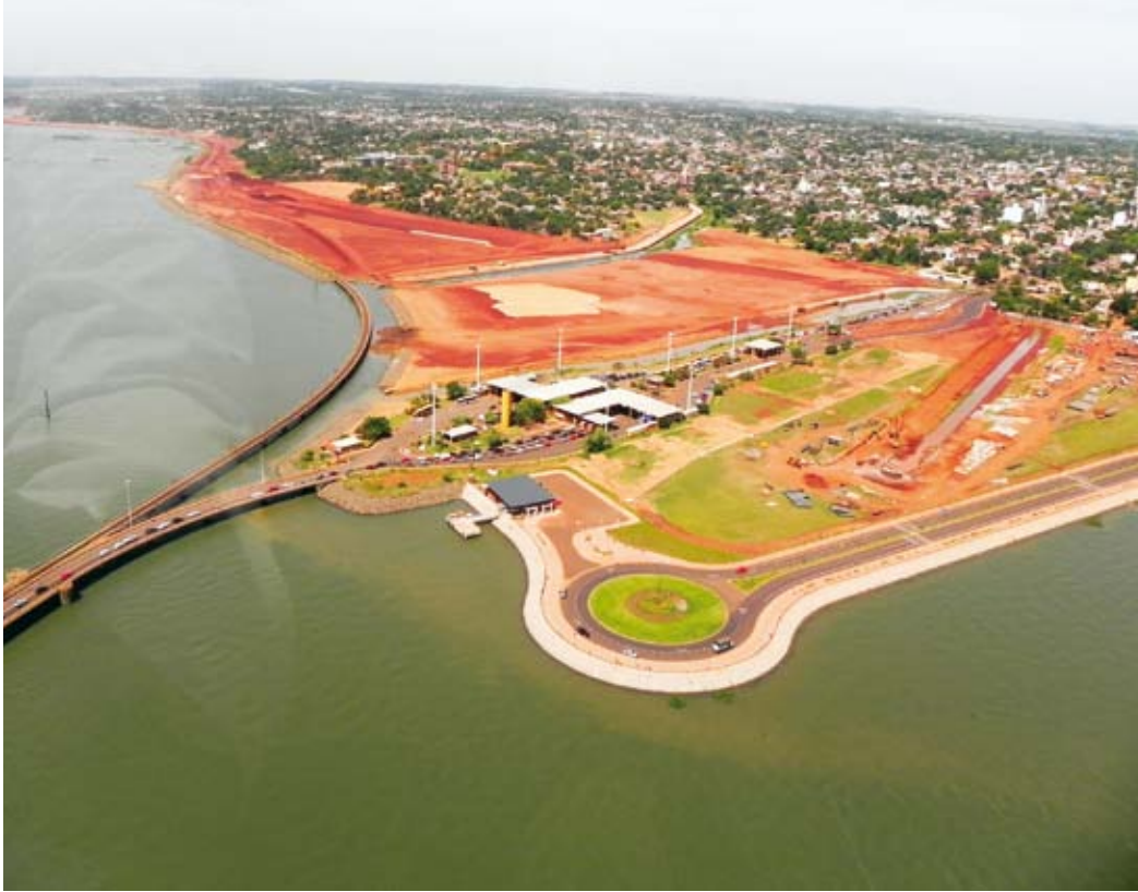
PUENTE SAN ROQUE GONZÁLEZ DE SANTA CRUZ. Control de Única Cabecera Posadas, Provincia de Misiones, Argentina. ACI Posadas - Encarnación.
