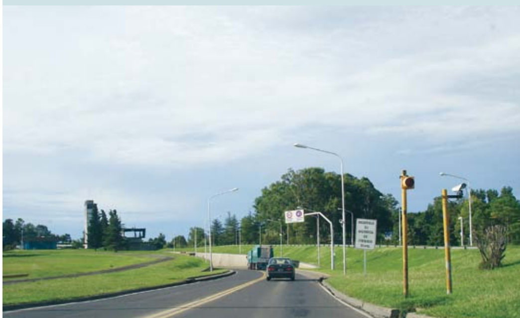
ACCESO TUNEL SUBFLUVIAL HERNANDARIAS. Paraná-Santa Fe, Argentina.
