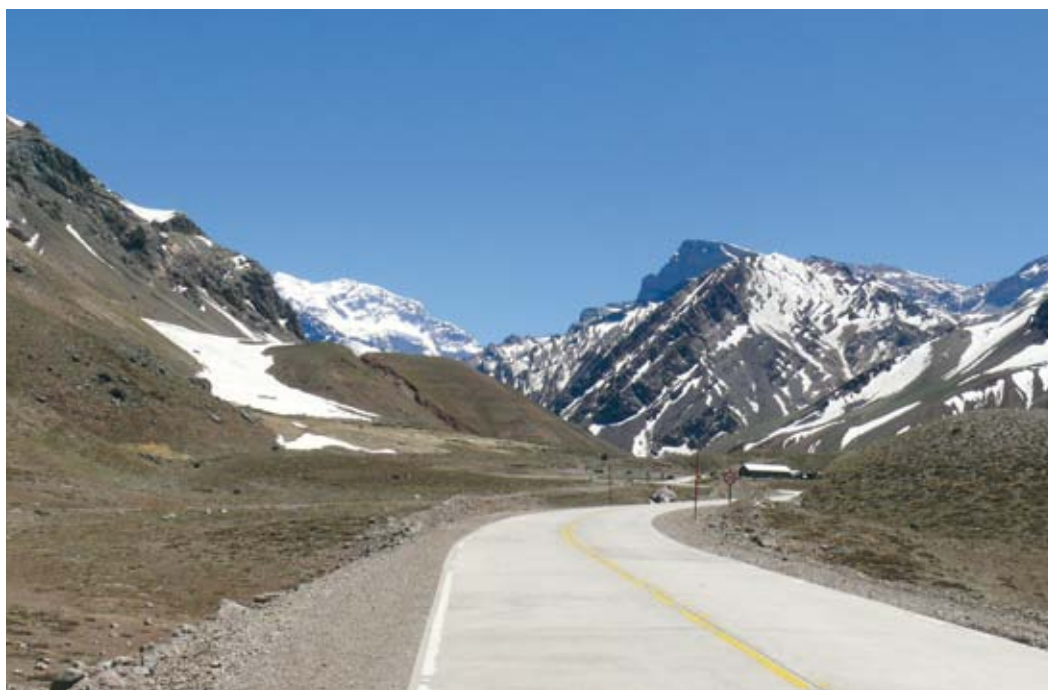
RN7. CAMINO AL TÚNEL CRISTO REDENTOR. Provincia de Mendoza, Argentina.
