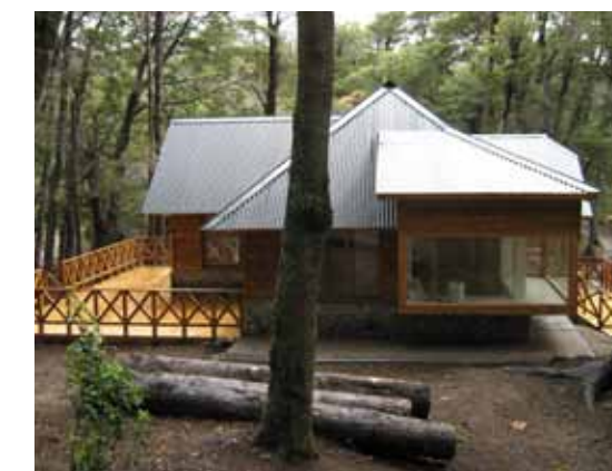
Construcción oficina de informes y sanitarios públicos.
